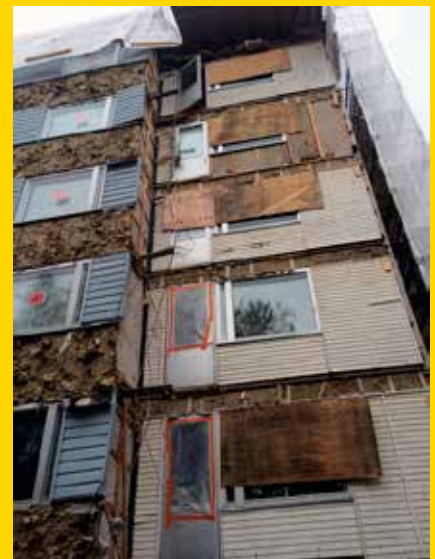
Korsossa 600m 2 ulkokuorien purkua ja parikymmentä parvekettä päälle.
