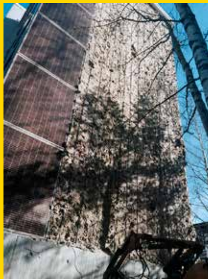
Lauttasaaressä ulkokuorien purkua 6-kerroksiseen taloon 2000m 2 .
