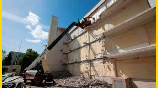
Porvoossa savupiipun ja parvekelinjojen purku.
