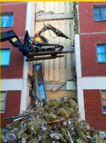
Ulko- ja sisäkuorien purkua itäkeskuksessa. Hisseille tehtiin 6 syvennystä.
