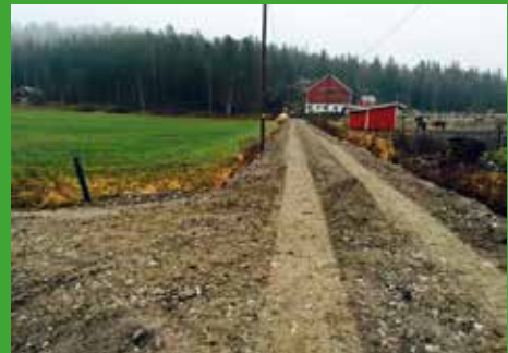
Betonimursketta hyötykäytetään mm. parkkialueiden ja teiden pohjissa.
