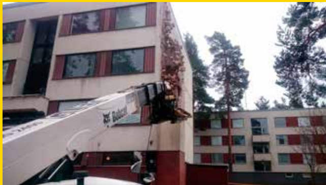
Porvoossa savupiipun ja parvekekaiteiden purku.
