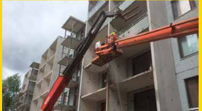
Parvekekaiteiden purkua 6-kerroksiseen taloon Järvenpäässä.
