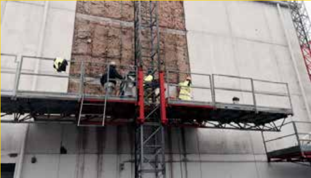
Julkisivun purkua 500m 2 käsin tilaajan toiveesta mastolaivoilla Kauniaisissa.
