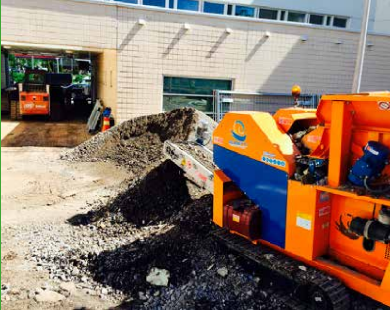
Guidetti Caesar 1 betonimurskain tekee purkujätteestä mursketta paikan päällä purkukohteessa.
